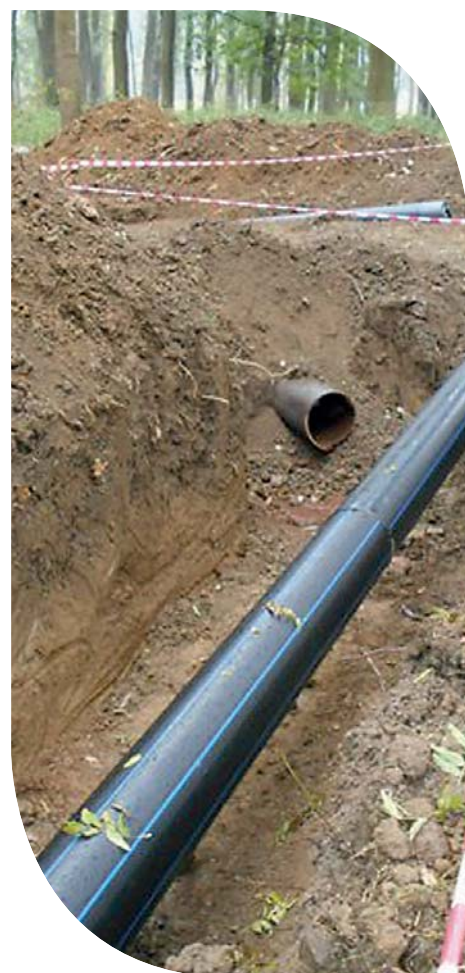
Vtahování nového PE potrubí – relining
