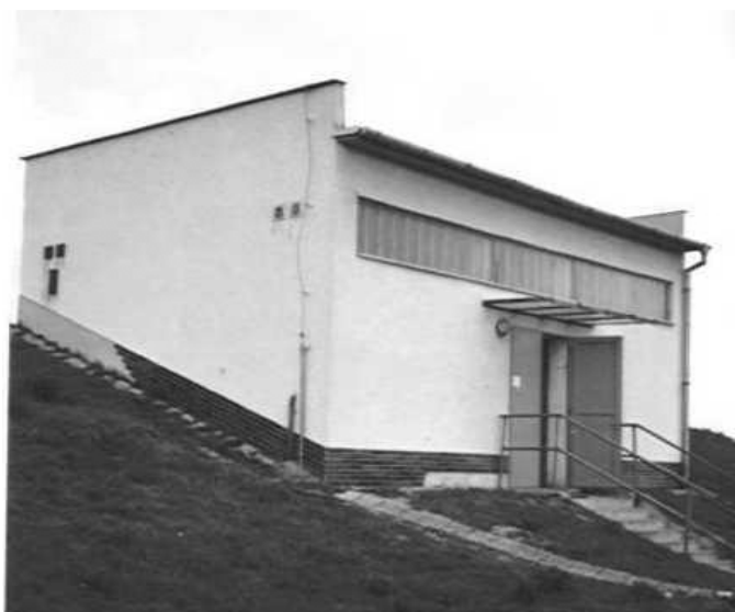
Obr.2. Armaturní objekt vodojemu 2 \times 650 \text{ m}^3 v Hrušovanech nad Jevišovkou.
