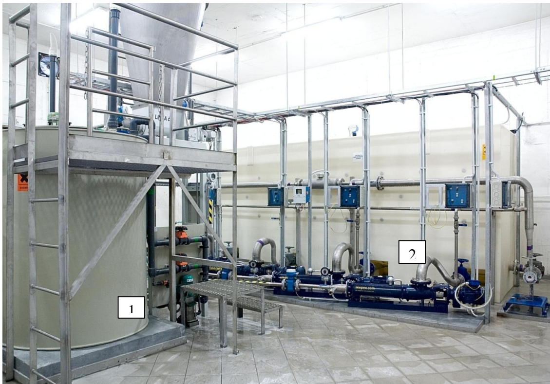
Obr. 3 Technologické schéma výroby a dávkování vápenné vody, sytič Passavant
