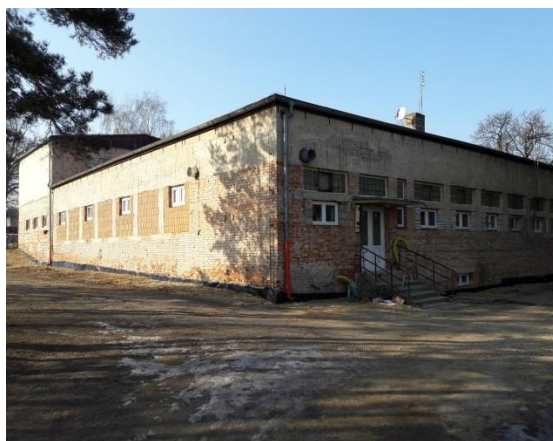
Obrázek 2: Úpravna vody Studeněves
