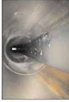
TRUBNÍ VEDENÍ PO SANACI BEZVÝKOPOVOU TECHNOLOGIÍ KAWO
