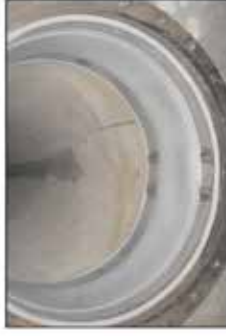
SANACE VODOVODNÍCH POTRUBÍ TECHNOLOGIÍ KAWEX
