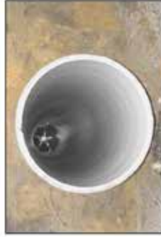
SANACE POTRUBÍ NÁSTRÍKEM TECHNOLOGIE SS SYSTÉM
