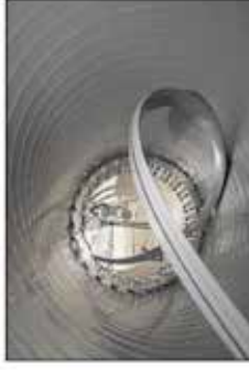
SANACE PRŮŘEZNÝCH PROFILŮ NÁVŮJENOU TECHNOLOGIÍ SPR - SYSTÉM
