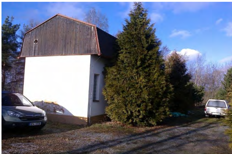
Obr. 5 a. Aplikace zařízení na výrobu směsných oxidantů pro oxidaci železa, manganu a dokonce i arsenu – pohled na úpravnu
