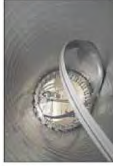
SANACE PRŮŘEZNÝCH PROFILŮ NAVŮJENOU TECHNOLOGIÍ SPR - SYSTÉM
