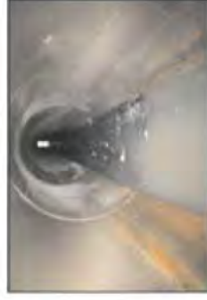
TRUBNÍ VEDENÍ PO SANACI BEZVÝKOPOVOU TECHNOLOGIÍ KAWO
