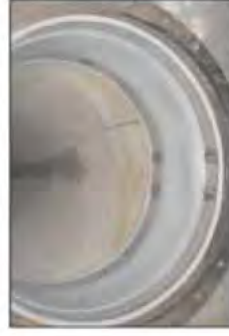
SANACE VODOVODNÍCH POTRUBÍ TECHNOLOGIÍ KAWEX
