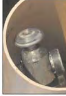
PRÁCE KANALIZAČNÍM ROBOTEM KAWO PRO LOKÁLNÍ OPRAVY POTRUBÍ
