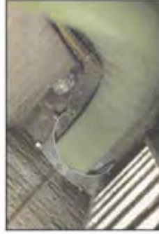
SANACE BEZVÝKOPOVOU TECHNOLOGIÍ OMEGA LINER
