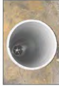
SANACE POTRUBÍ NÁSTRÍKEM TECHNOLOGIE SS SYSTÉM
