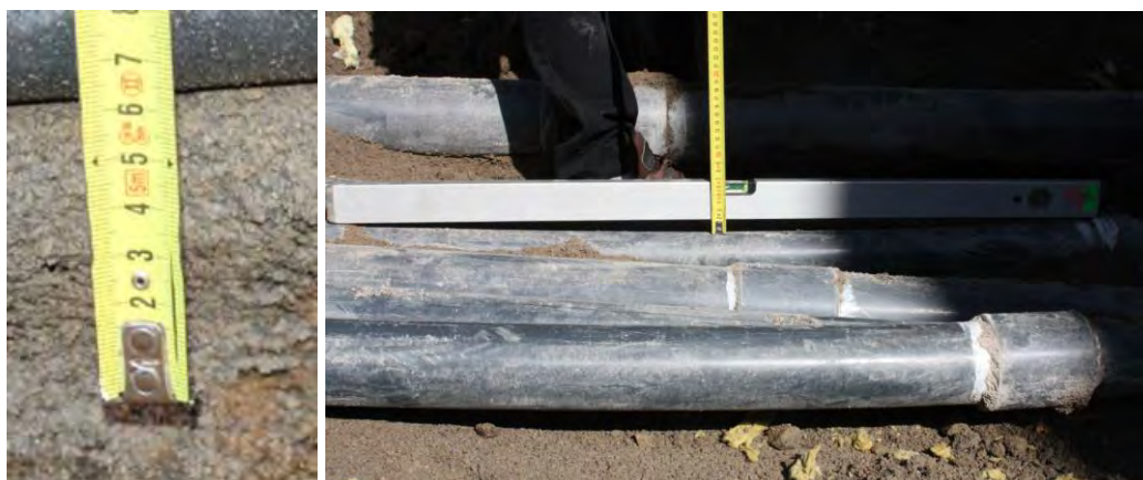
Obr. 8 Pohled na výšku podsypu potrubí a na průhyby položených potrubí.
