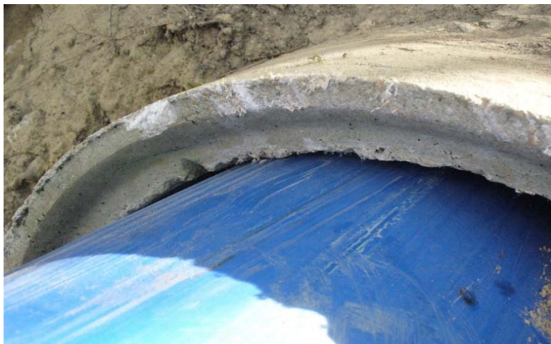
Obr. 4 PE potrubí během instalace
