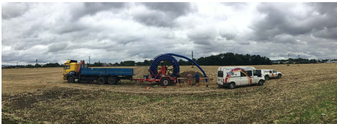
Obrázek 1: Instalace potrubí Compact Pipe
