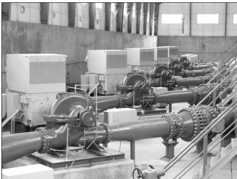
Obr. 11 Kompromisní řešení zabudování zpětné klapky na rozšířeném potrubí
