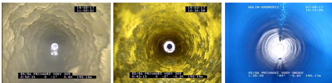
Obrázek 3: Stav potrubí před čištěním, po čištění a po sanaci metodou Compact Pipe
