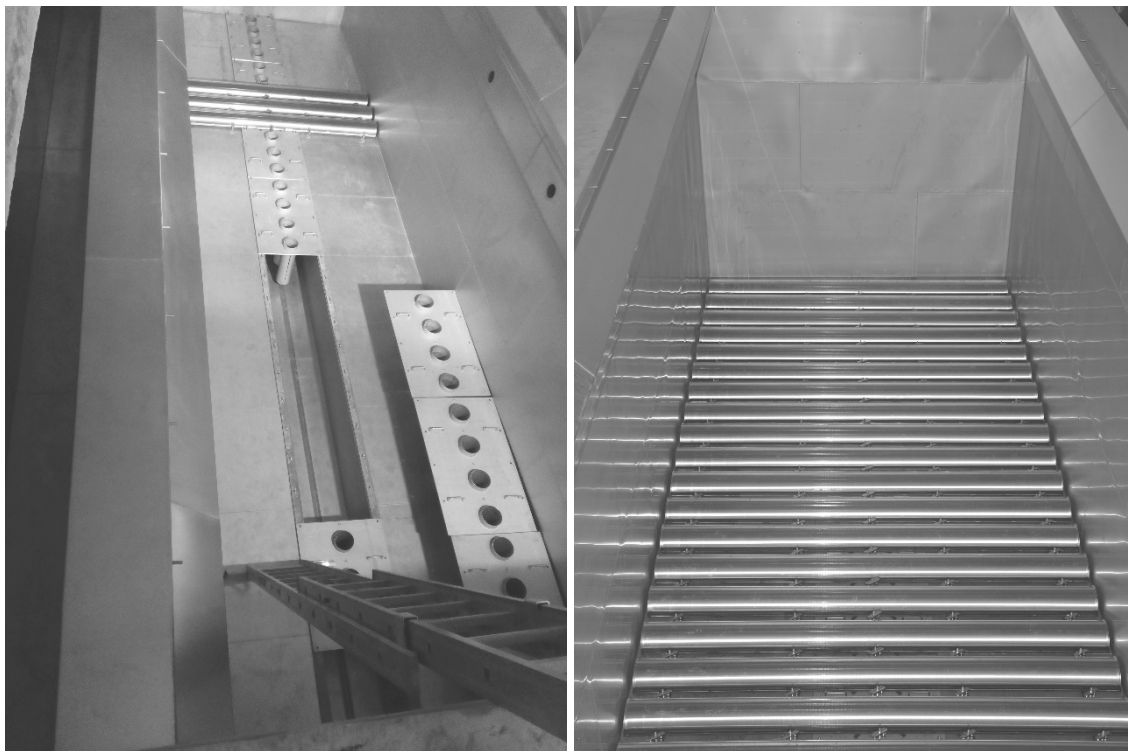
Obr. 4 Instalace drenážního systému TRITON
