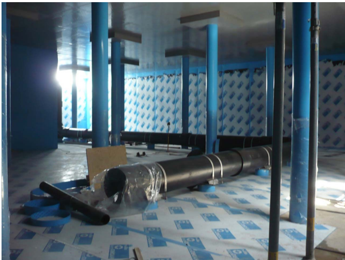
Obrázek 9 Montáž potrubí ve vodojemu
