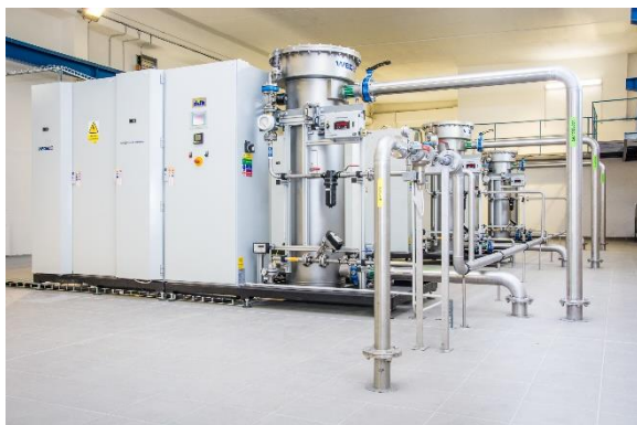
Obr. 1: Generátory ozonu na ÚV Plzeň
