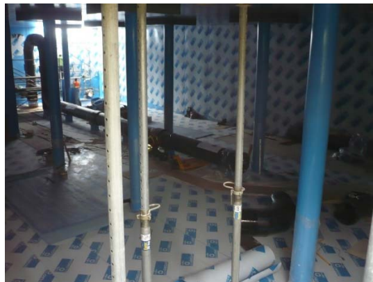
Obrázek 8 Montáž plastové vystýlky
