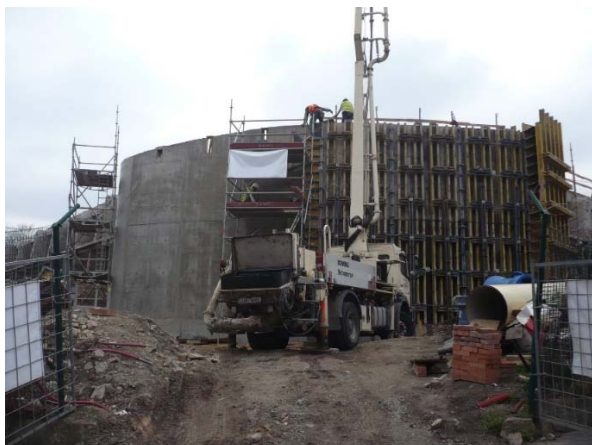
Obrázek 4 Betonáž průčelí nové čerpací stanice
