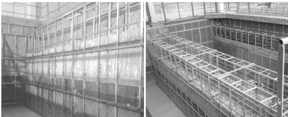
Obr. 2 Realizace nosné konstrukce pro oplechování
