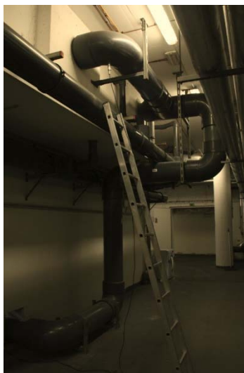
Obr. 4 Sací potrubí čerpadla s množstvím směrových lomů a osazení sond ultrazvukového průtokoměru a snímače tlaku.
