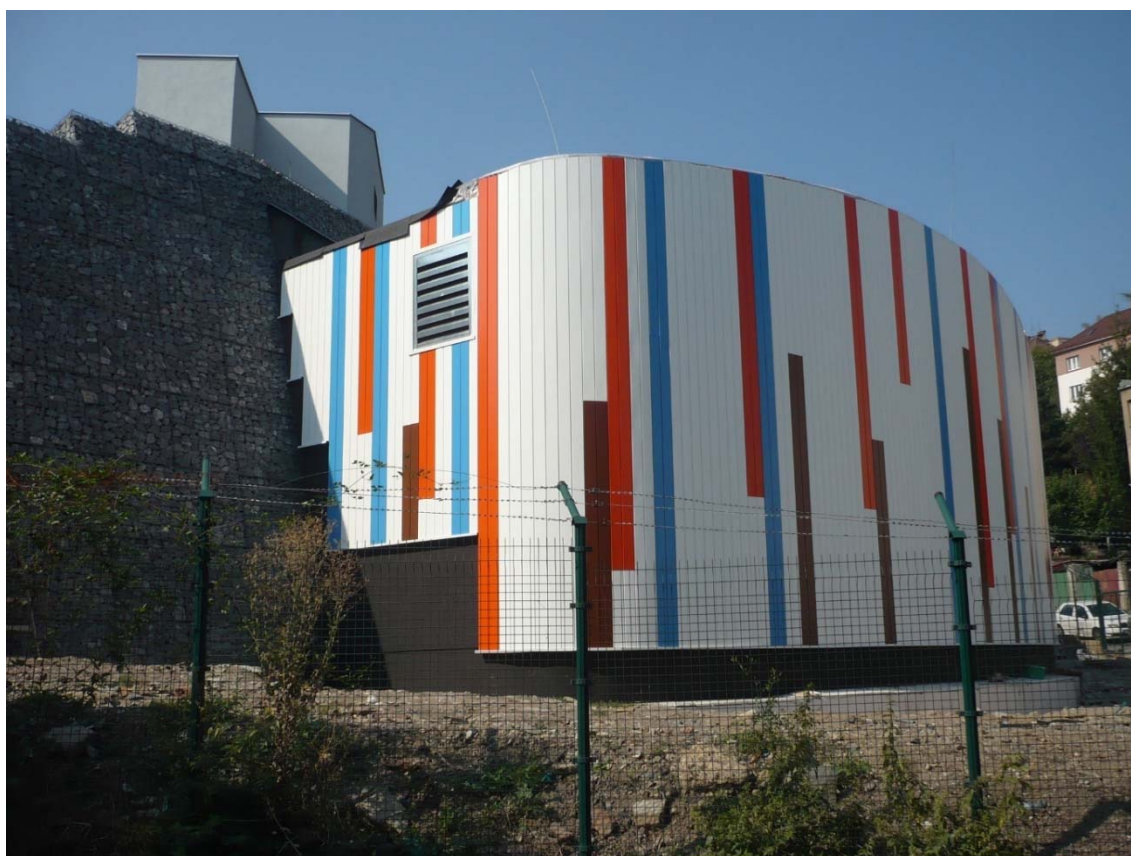
Obrázek 5 Čerpací stanice vodojemu Laurová po rekonstrukci
