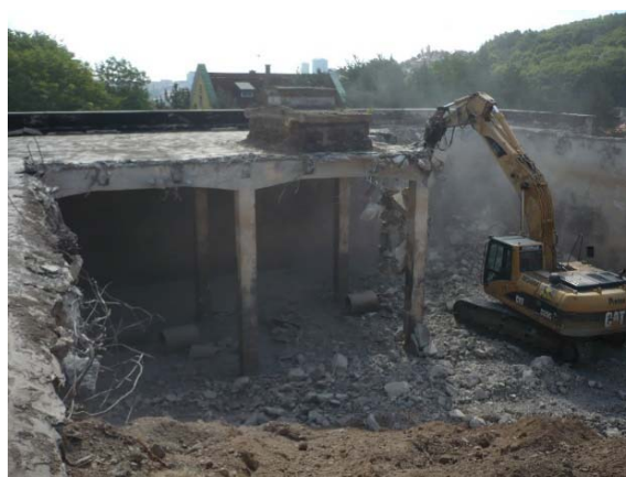
Obrázek 3 Demolice stropu a sloupů stávajícího vodojemu
