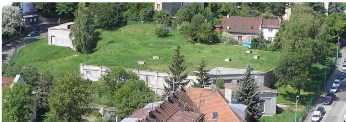
Obrázek 1 Celkový pohled na vodojem Laurová před zahájením rekonstrukce
