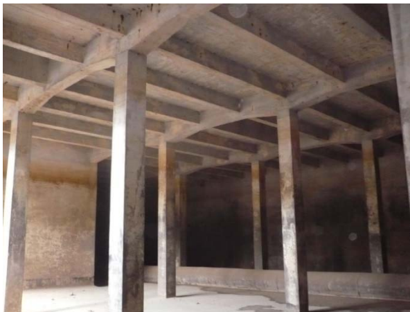
Obrázek 6 Stávající strop a podpěrné sloupy vodojemu
