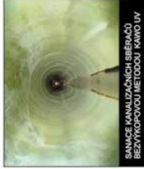
DIAGNOSTIKA PODZEMNÍCH TRUBNÍCH VEDENÍ TV - KAMEROU
