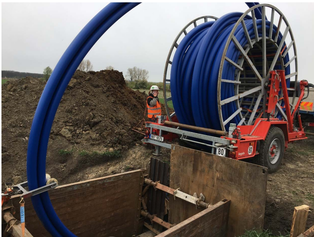
Obrázek 2: Proces zatahování potrubí Compact Pipe z cívky.
