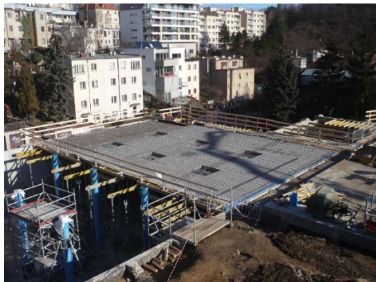
Obrázek 7 Pohled na armování stropní desky vodojemu, jsou zde vidět položené plastové desky do bednění
