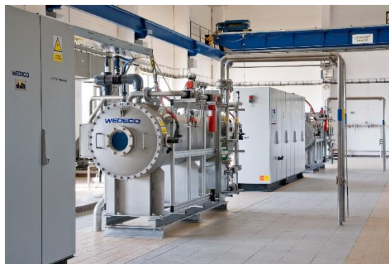
Obr. 2: Generátory ozonu na ÚV Želivka
