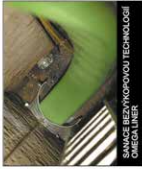
PRÁCE KANALIZAČNÍM ROBOTEM KAWO PRO LOKÁLNÍ OPRAVY POTRUBÍ
