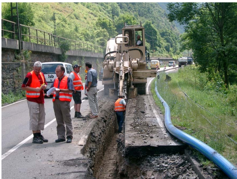
Obr. 8 Instalace potrubí s bariérou technologií frézování
