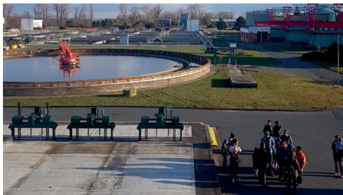
Čistírna odpadních vod Olomouc
