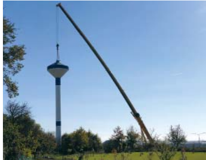
Dokončení usazování hlavy vodojemu
