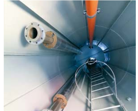
Vnitřek vodojemu po dokončené rekonstrukci
