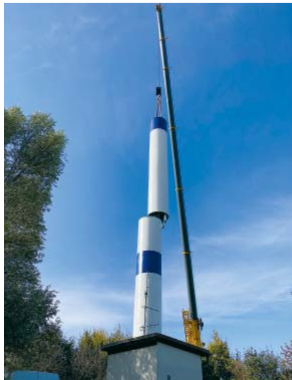
Usazování částí dřívku vodojemu
