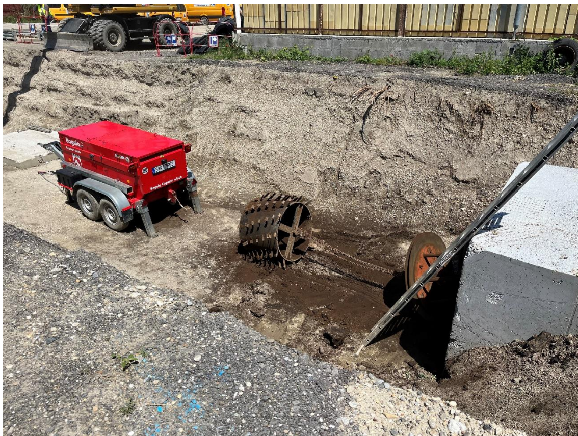
Obr. 3, 4 Sanace v Bratislavě – mechanické čištění a příprava PE potrubí
