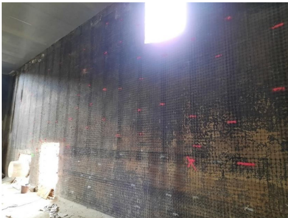
Obr. 5 Použití inertní sítě ke kotvení sanačních hmot
