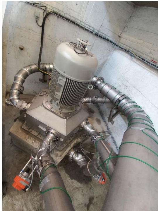
Obr. 3 Vertikální pětistruská Peltonova turbína
