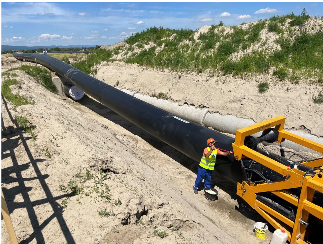
Obr. 5 Sanace v Bratislavě – zatahování PE potrubí metodou Dyntec
