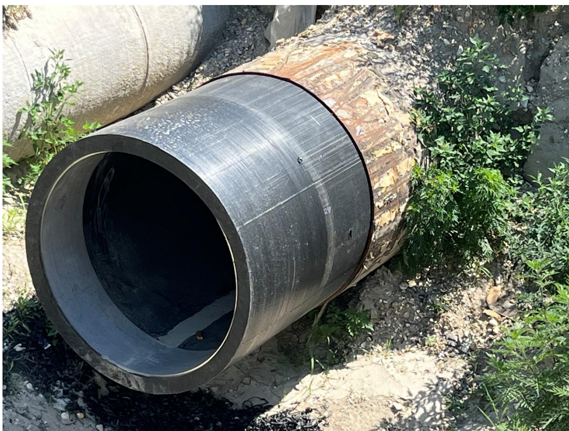
Obr. 2 Sanace ocelového vodovodu d1200 v Bratislavě – close-fit efekt
