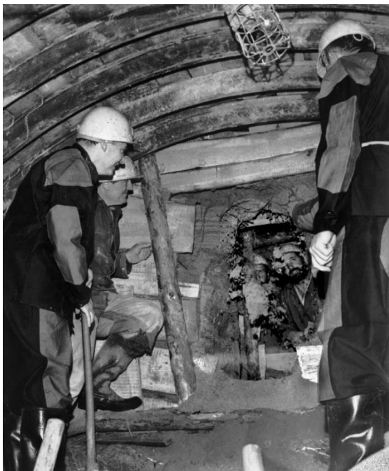
Obr. 1 Stavba štolového přivaděče – prorážka
