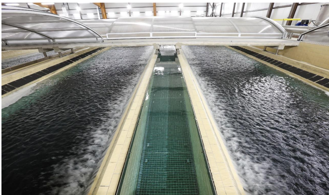
Obr. 2 Pohled do filtrů s náplní granulovaného aktivního uhlí
