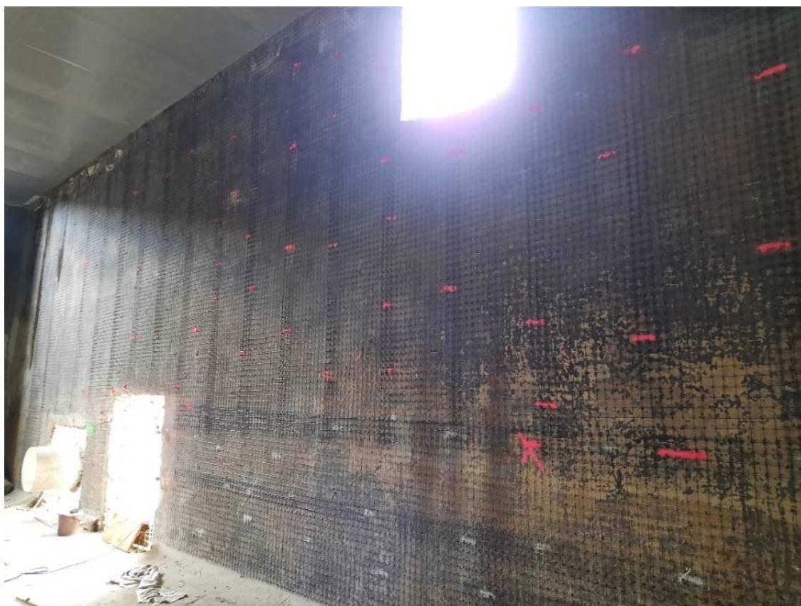
Obr. 4 Použití inertní sítě ke kotvení sanačních hmot
