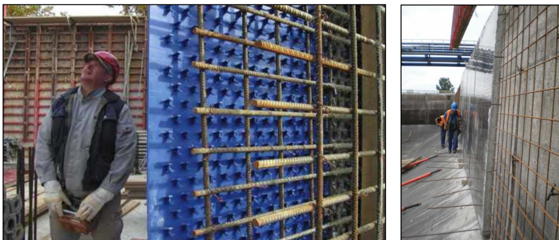
Obr. 12 Vystýlky nových konstrukcí a přibetonávek
