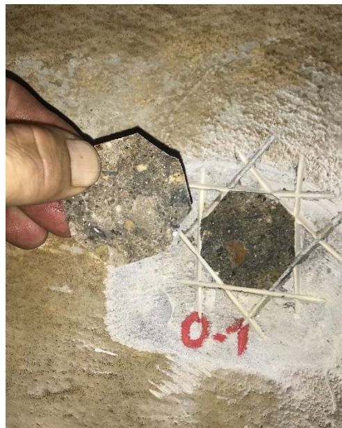
Obr. 3 Místo po provedení odtrhové zkoušky na stanovení pevnosti povrchové vrstvy betonu v tahu
