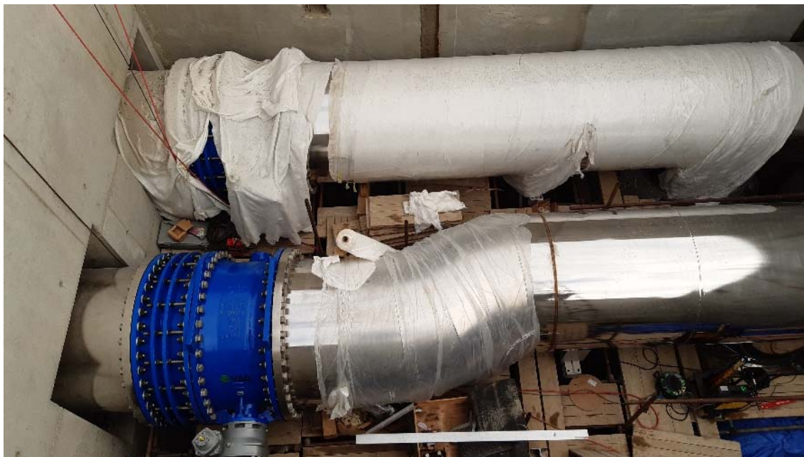
Obr. 8 Ukázka ochrany potrubí během stavby, nového svaru a ošetřeného svaru
