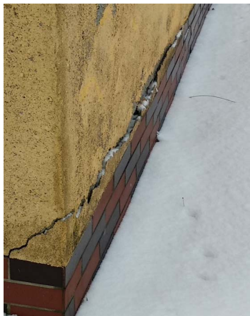
Obr. 8 Uvolněný kabřincový obklad, spára vyplněná sněhem
