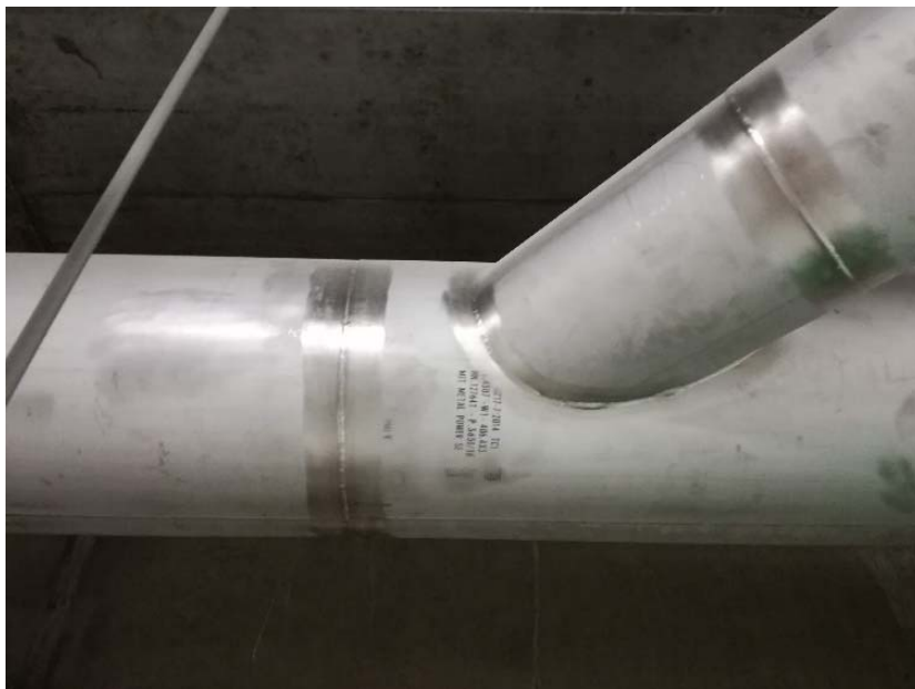
Obr. 9 Správně provedený a ošetřený svar
