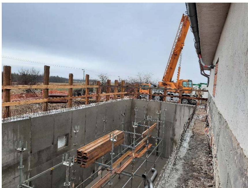
Obr. 7 Přibetonávka po odbednění
