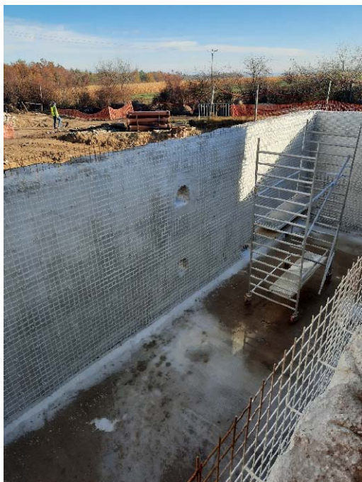
Obr. 8 Mechanicky kotvená síť
