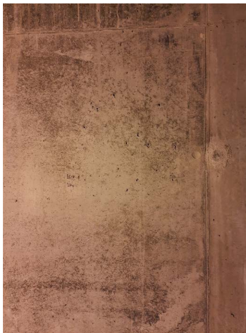
Obr. 9 Povrch po odbednění
