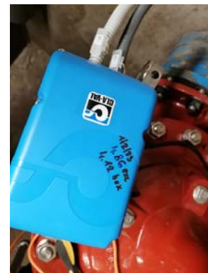
Připojovací detail svorkovnice CLA-VAL:
