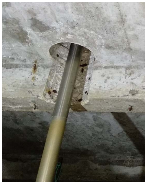
Obr. 7 Jádrový vývrt skrz stropní trám
