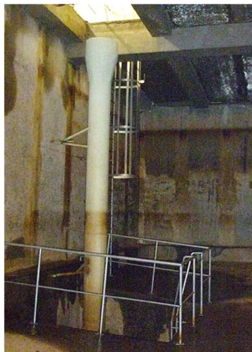
Obr. 9 Vhodné řešení bezpečnosti v akumulční nádrži
