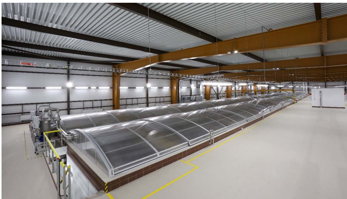
Obr. 1 Pohled do 2. nadzemního podlaží haly GAU filtrace
