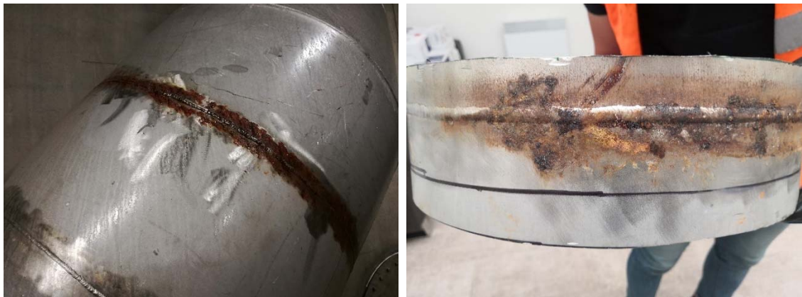
Obr. 1 Nesprávně provedené svary
