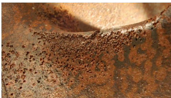
Obr. 4 Kavitační eroze na oběžném kole čerpadla
