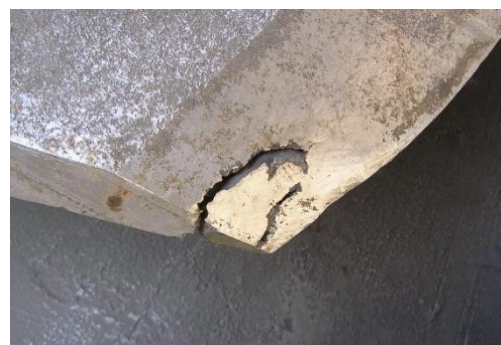
Obr. 5 Kavitační poškození lopatky čerpadla
