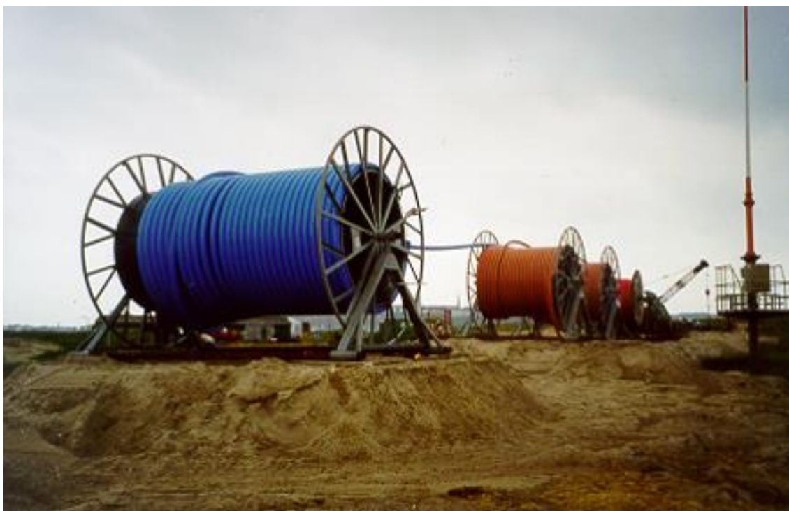
Obr. 2 (2000): Obnova vodovodní sítě v dunách ostrova Helgoland. Instalace chráničky pomocí SLA® Barrier Pipes pro přívodní a odpadní potrubí pod mořským dnem.
