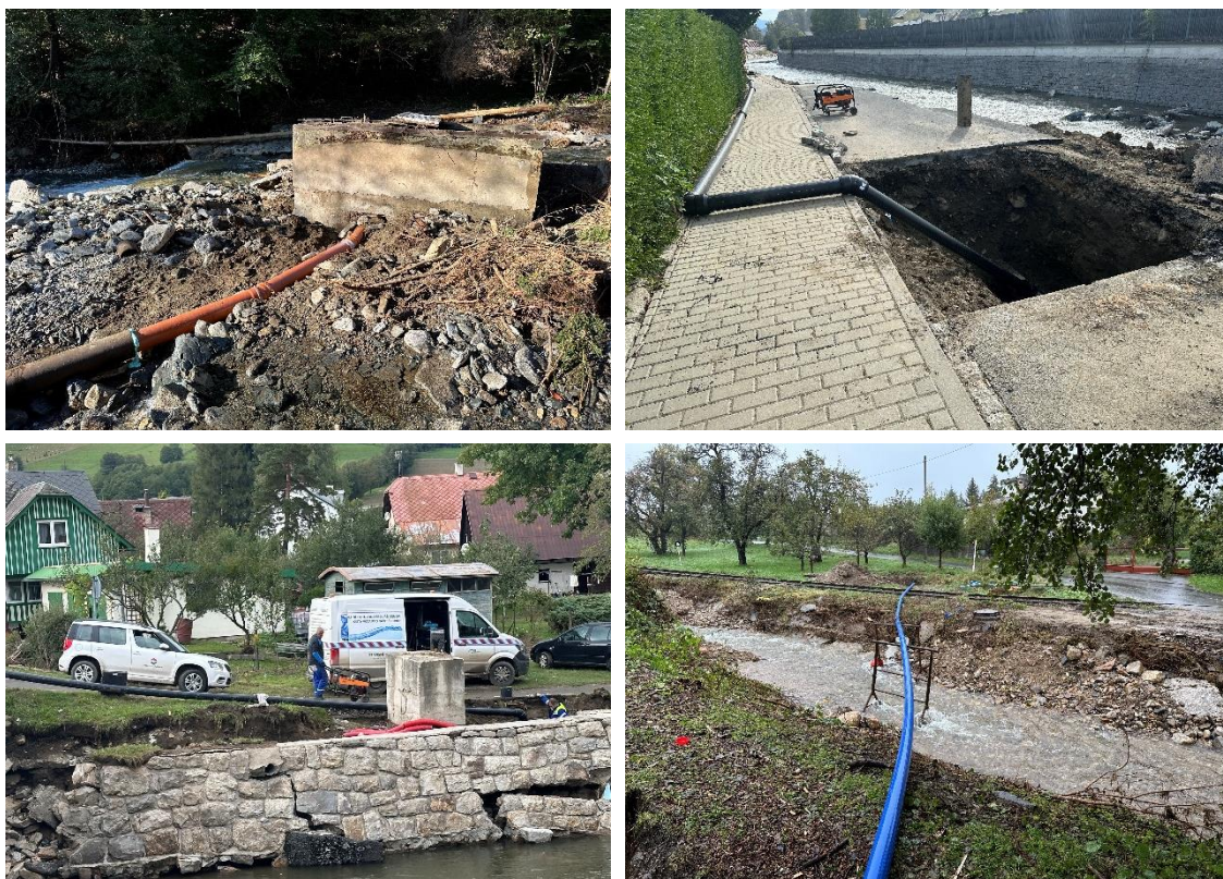
Obrázek 11-14 Provizorní opravy při zprovoznění VHI
