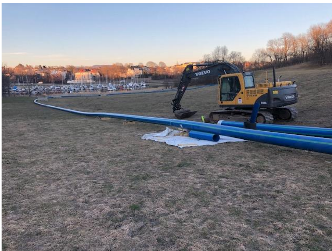
Obr. 7 (2019): Nové propojení ostrovů Bygdøy a Hovedøya v Osloském fjordu s vodovodní sítí. I město Oslo si pro tento projekt vybralo potrubí SLA® Barrier Pipes.
