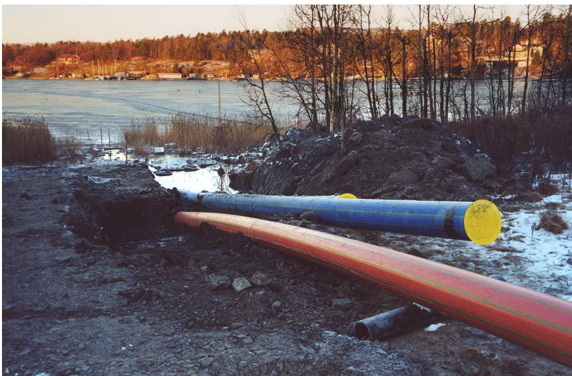
Obr. 3 (2001): Bezvýkopová pokládka SLA® Barrier Pipes v chemicky kontaminovaném vodním toku poblíž Osla.
