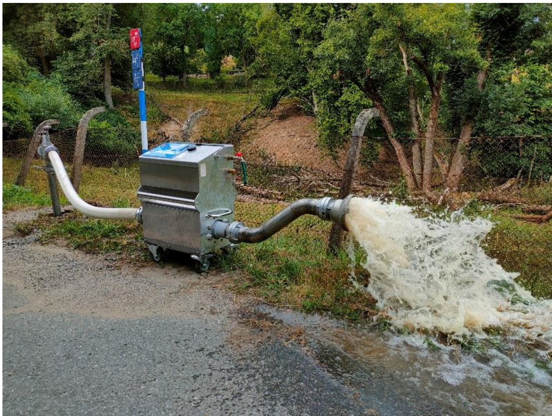
Obr. 2 Čištění potrubí řízeným proplachem - Technologie Astacus, současně se automatizovaně měří a vyhodnocuje teplota, tlak, průtok a objem vypouštěné vody
