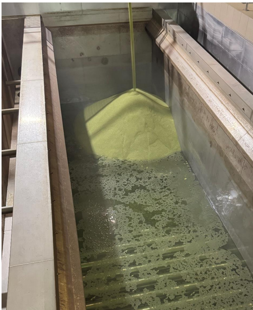
Obr. 6 Plnění filtru materiálem GreenFil na ÚV Sojovice
