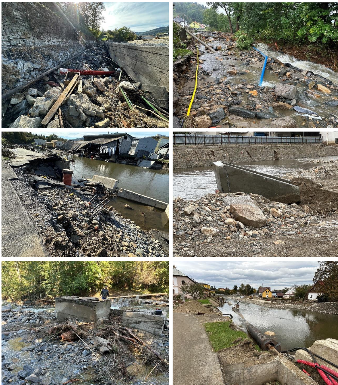
Obrázek 1-6 Povodňové škody na různých částech VHI
