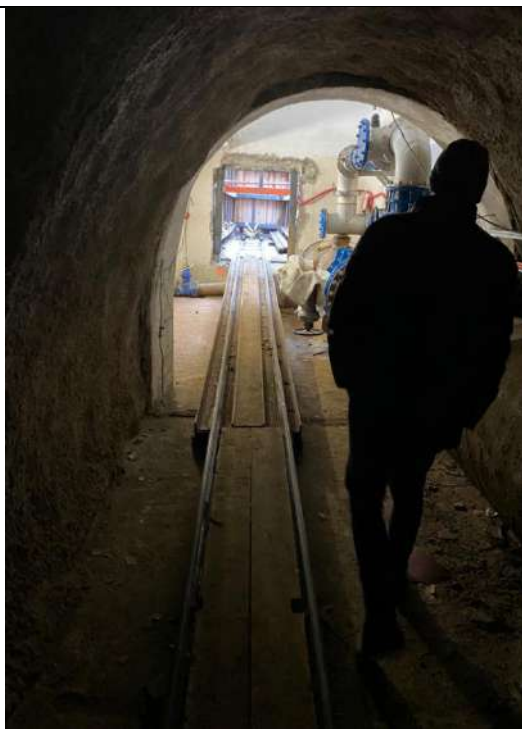
Obr. 4 Průhled přes dolní portál do startovací jámy a kolejová trasa pro zavážení potrubí do štoly
