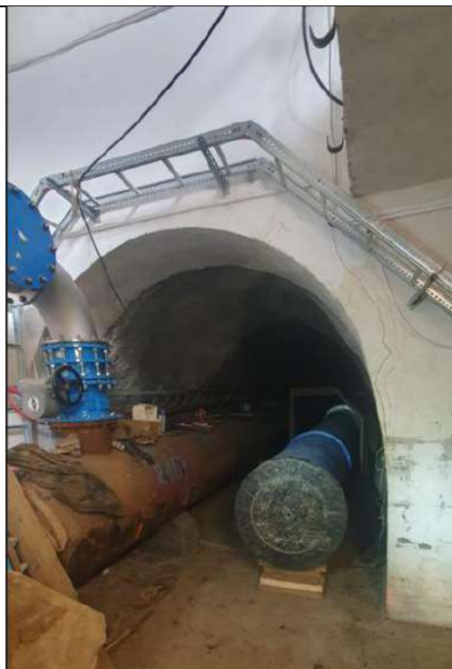
Obr. 5 Pohled z dolního portálu na poslední uloženou troubu ve štole
