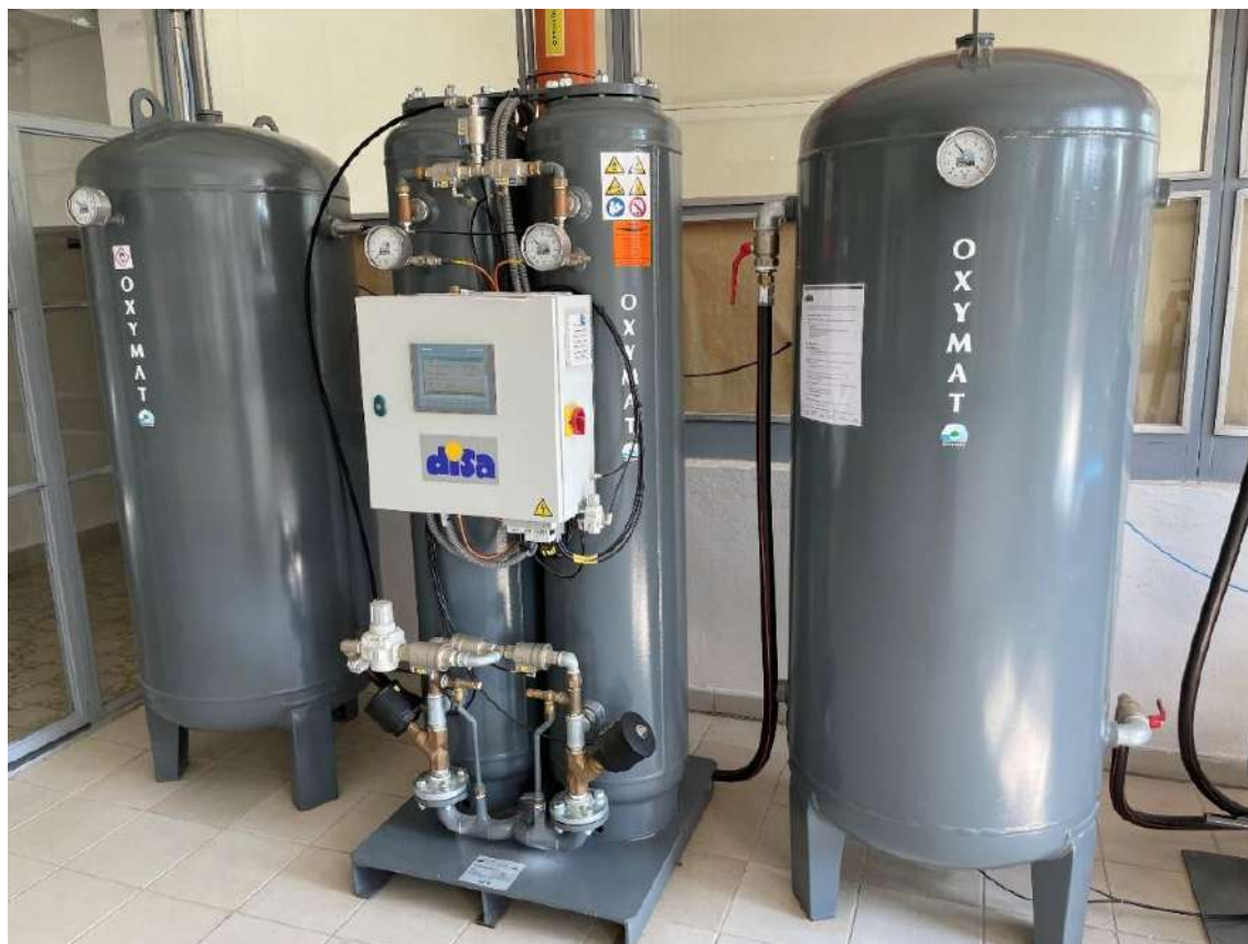
Obr. 2 Generátor kyslíku Oxymat s kapacitou 10 Nm 3 /h
