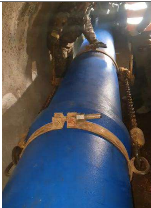
Obr. 6 Montáž potrubí ve štole, nasouvání potrubí do hrdla.
