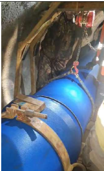
Obr. 6 Montáž potrubí ve štole, nasouvání potrubí do hrdla.
