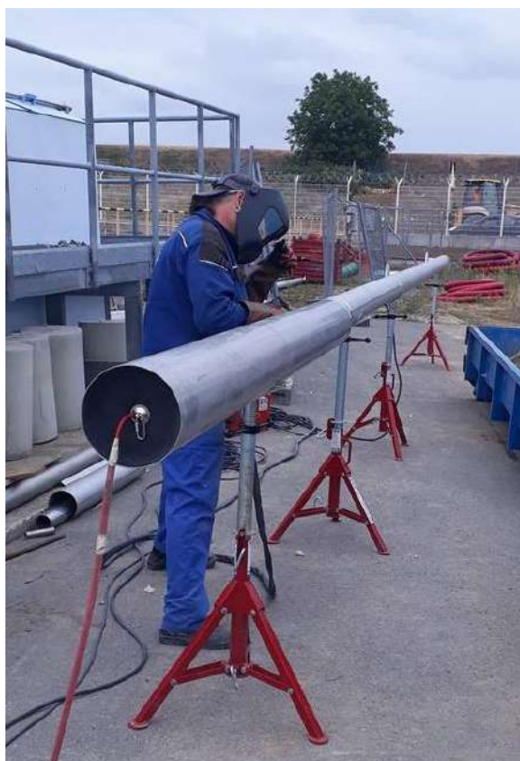
Obr. 2 Ukázka uzavření rovného potrubí a formování svaru
