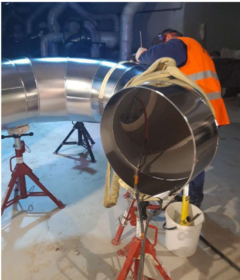
Obr. 4 Ukázka svařování a formování svaru segmentového kolena
