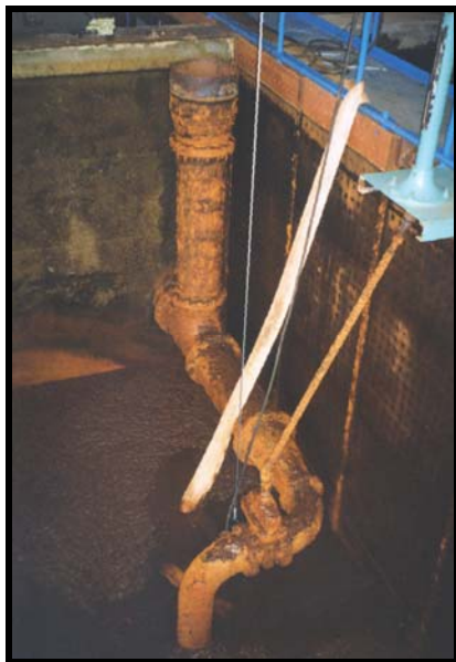
Odčerpávání kalu z původních kalových jímek sedimentačních nádrží
