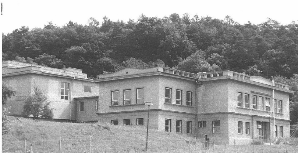
Obr. 5 - budova úpravny vody v Koryčanech
