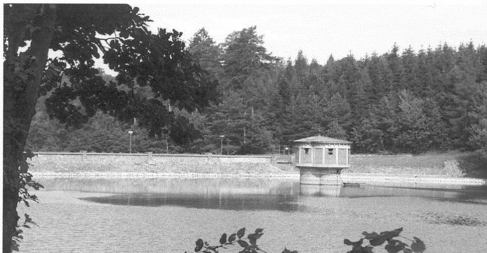
Obr. 4 - vodní nádrž Koryčany s odběrnou věží
