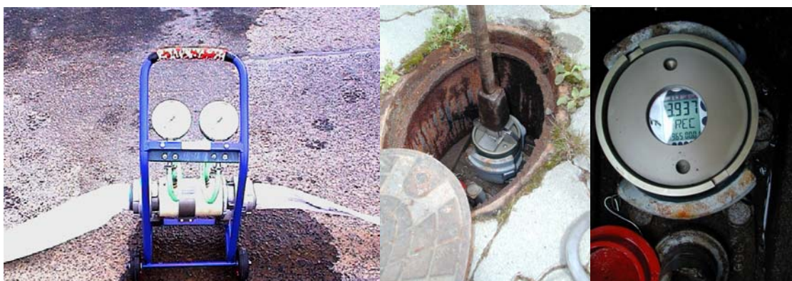
obr. č. 2 - Na obrázcích je dokladována měřící souprava průtoku pro hydrantové testy, manometr SEWAD a jeho montáž na hydrant
