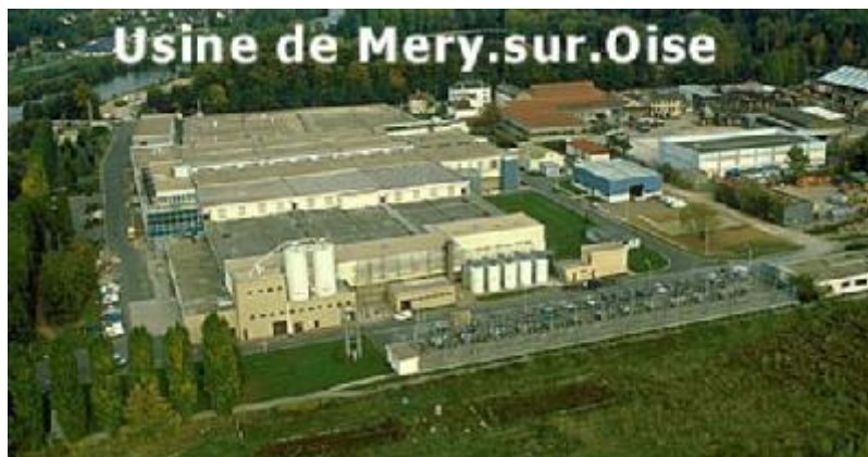
Obr. 6. Celkový pohled na NF linku ÚV Méry sur Oise.
