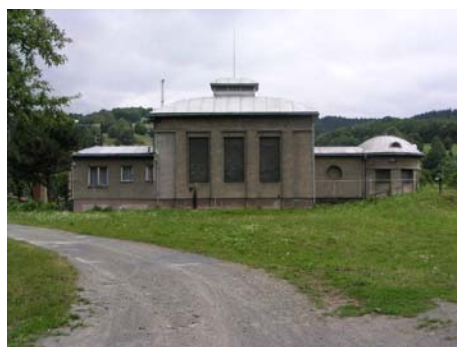
Obr. č. 2: Čerpací stanice Vsetín – Ohrada (objekt čerpací stanice před rekonstrukcí)
