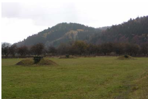
Obr. č. 1: Čerpací stanice Vsetín – Ohrada (prameniště)
