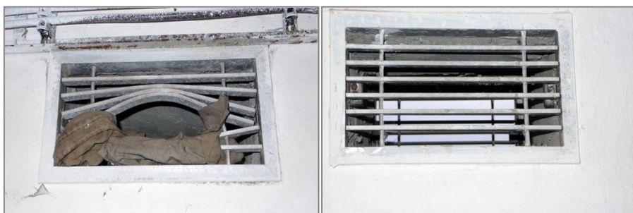
Obr. 5. Nevhodně zajištěné větrací otvory v prostoru manipulační komory s čerpací stanicí
