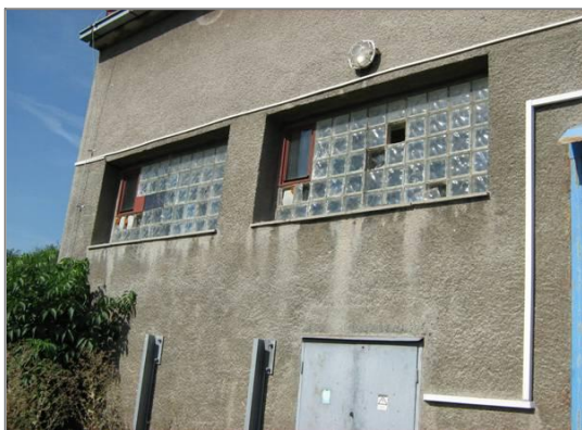
Obr. 1. Pohled na manipulační komoru s porušenými okny (luxfer).
