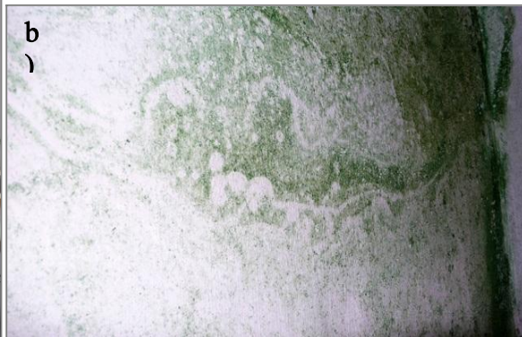
Obr. 4. Vlhké zdi akumulční komory v prostoru manipulační komory s čerpací stanicí, v níž jsou velká okna. Odvětrání bylo vybudováno podle ČSN 73 6650. Položka a) ... celkový pohled,
