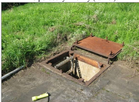
Obr. 2. Vstup do akumulční nádrže přímo v rohu ploché střechy.
