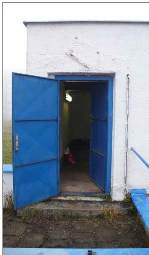
Obr. 3. Vstup do prostoru k akumulčním nádržím.
