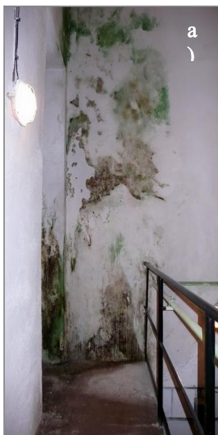
Obr. 4. Vlhké zdi akumulční komory v prostoru manipulační komory s čerpací stanicí, v níž jsou velká okna. Odvětrání bylo vybudováno podle ČSN 73 6650. Položka a) ... celkový pohled,
