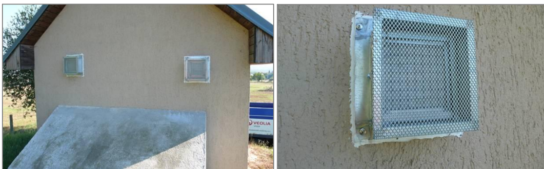
Obr. 20. Příklady vhodného zajištění větracích otvorů rámečky s filtrační textilií.
