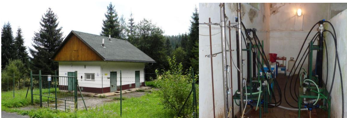
Ob. 1 Pohľad na vodárenský objekt v Dúbrave a na použité filtračné zariadenie
