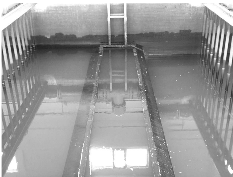
Obr. 4. Nestejná výška hladin u filtru při filtraci (až 30 cm)
