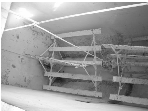
Obr. 5 ÚV Stakčín - nádrž vápenného mléka před renovací, horizontální pádlová míchadla po čištění
