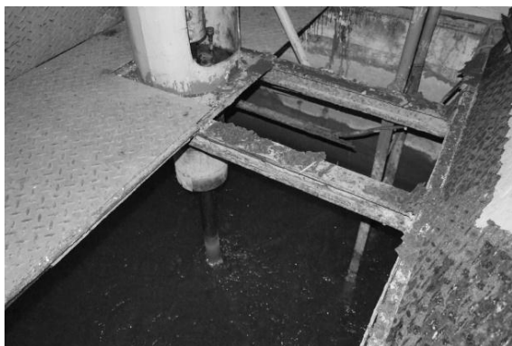
Obr. 1 a 2: ÚV Nová Bystrica, rychlomísení před renovací s rotačními vertikálními míchadly
