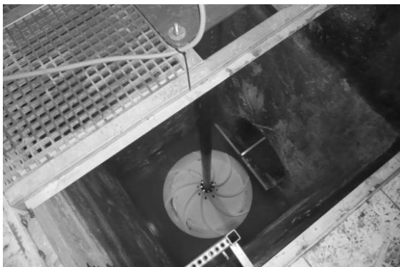
Obr. 3 a 4: ÚV Nová Bystrica, renovace rychlomísicích komor, instalace hyperboloidních míchadel
