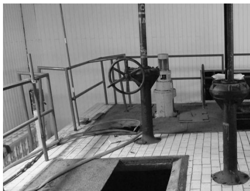
Obr. 1 a 2: ÚV Nová Bystrica, rychlomísení před renovací s rotačními vertikálními míchadly
