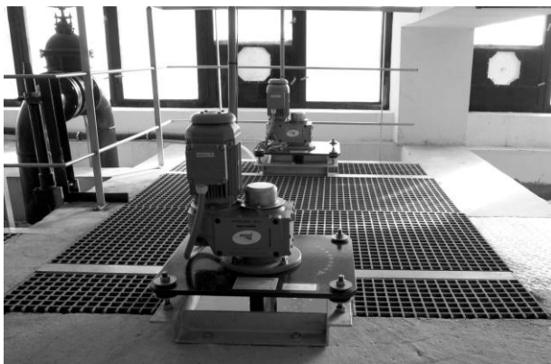
Obr. 7 ÚV Stakčín – pohled shora na pochozí plochu jedné nádrže vápenného mléka po rekonstrukci - s pohony hyperboloidních míchadel
