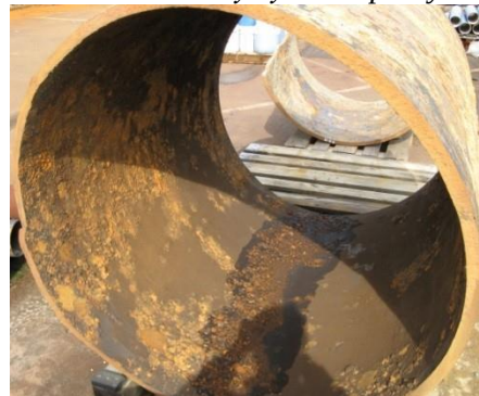
DN 1100 současný výřez z opravy
