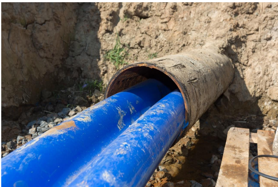
Obr. 2 Stávající ocelový vodovod DN350 během sanace
