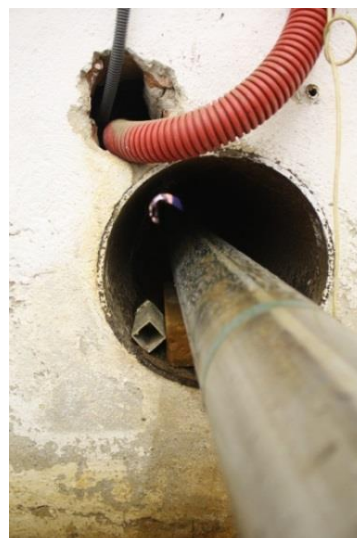
Obr. 3 – Typická uspořádání armaturních komor a chránička mezi zhlavím vrtu a armaturní komorou
