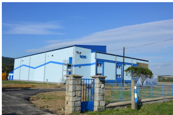
Obrázek č. 1: Objekt úpravný vody
