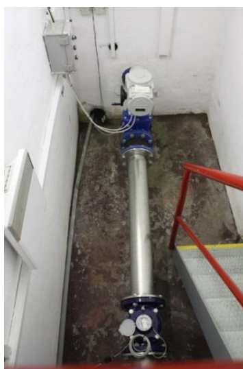
Obr. 3 – Typická uspořádání armaturních komor a chránička mezi zhlavím vrtu a armaturní komorou
