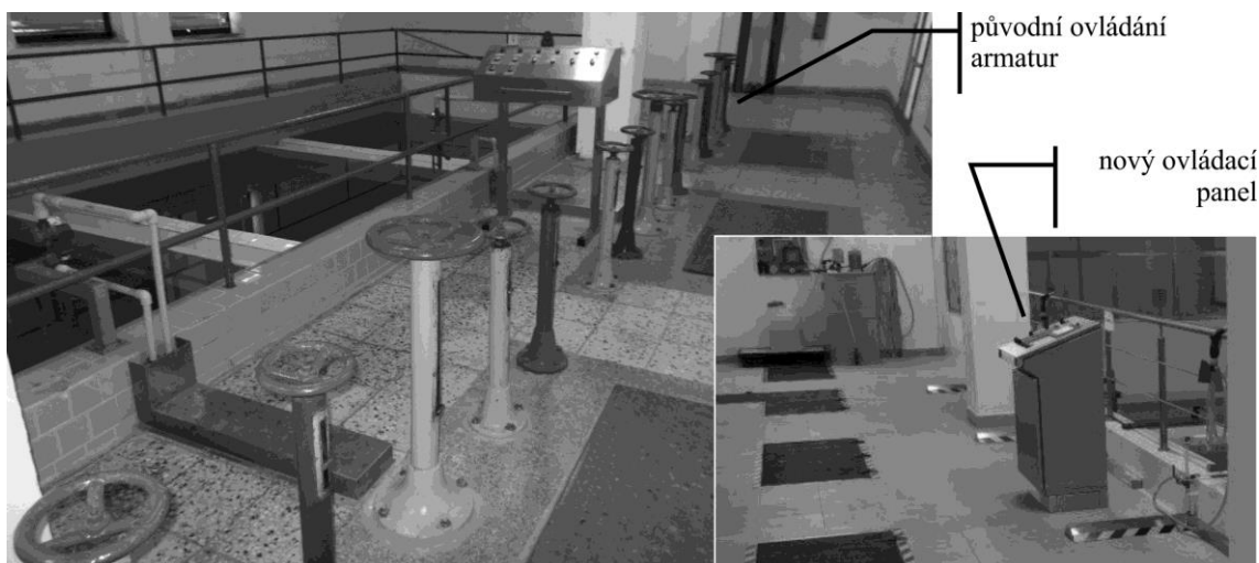
Obr. 2 Ovládání pracích cyklů před a po rekonstrukci ÚV Osuské
