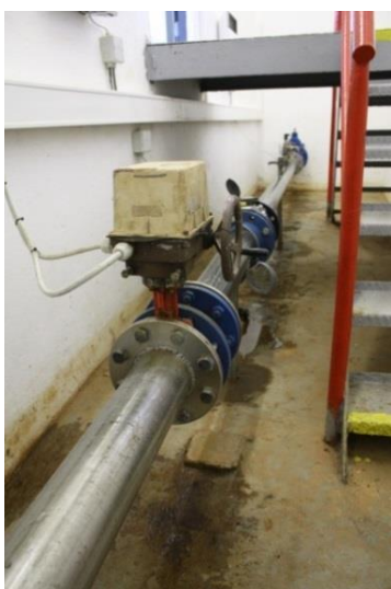
Obr. 3 – Typická uspořádání armaturních komor a chránička mezi zhlavím vrtu a armaturní komorou
