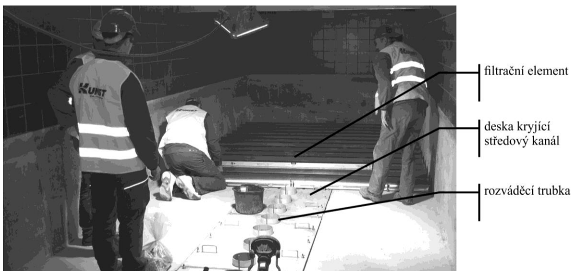
Obr. 3 Montáž drenážního systému TRITON (ilustrační foto)
