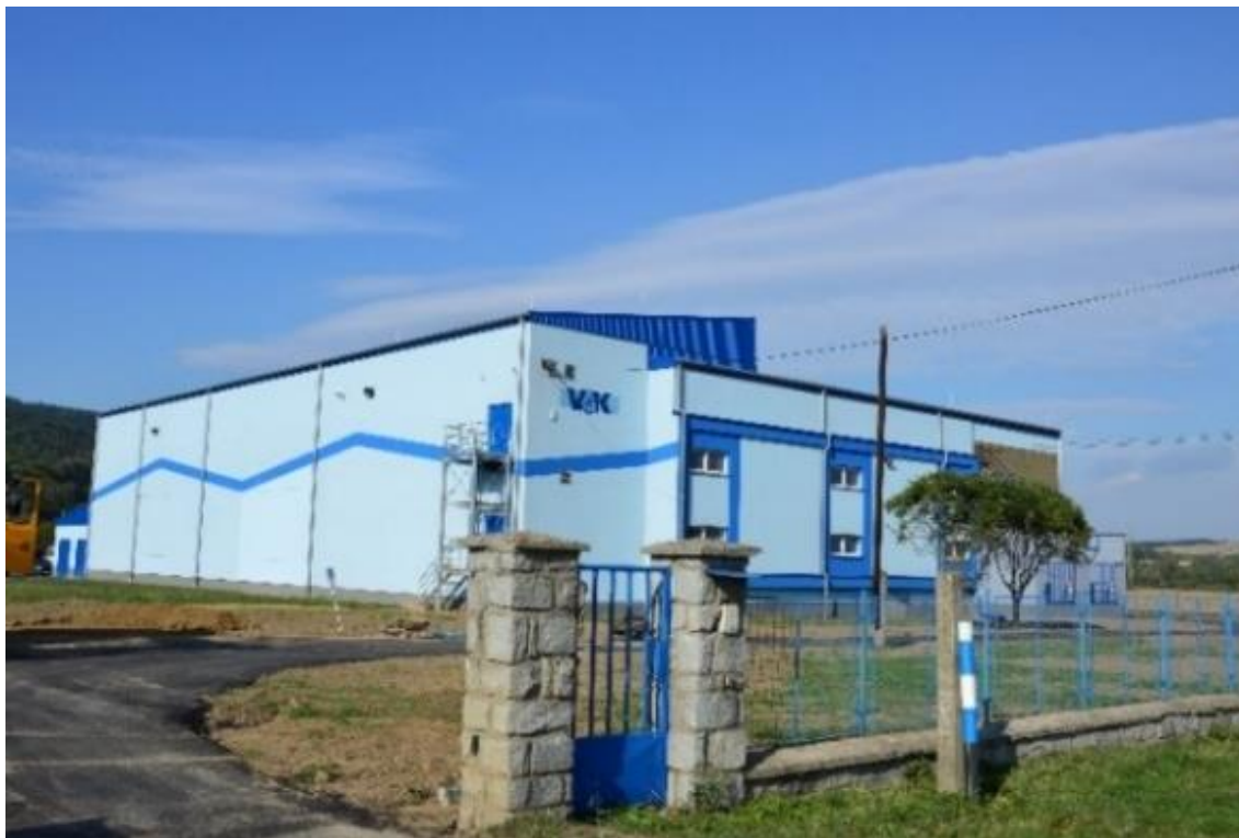
Obr. 1 Modernizovaná úpravna vody ve Valašském Meziříčí
