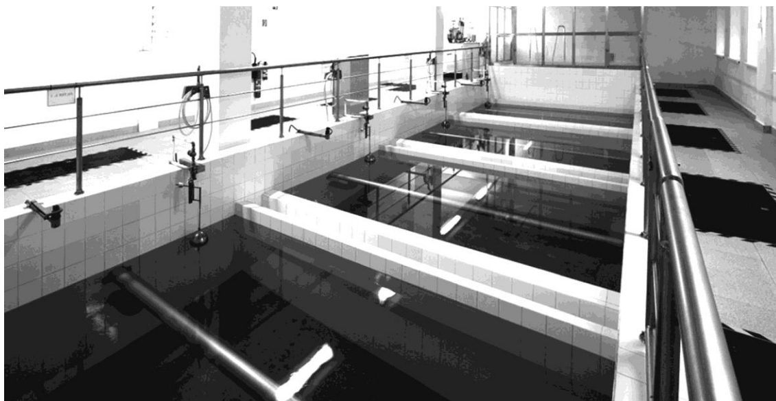
Obr. 4 Pohled na rekonstruované pískové filtry (v pozadí zasklená provzdušňovací komora)
