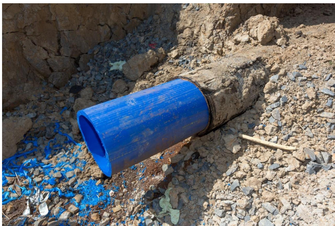
Obr. 7 Těsně napasovaný PE dohromady s původní ocelí
