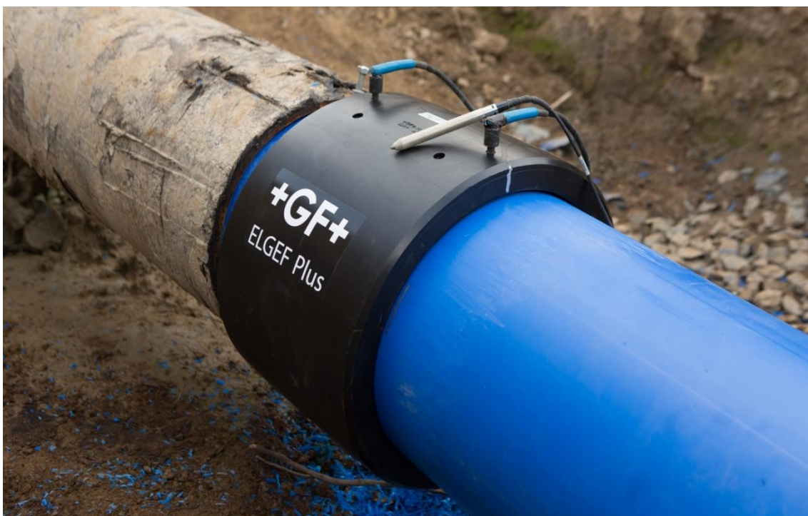
Obr. 9 Spoj elektrospojku jako součást propoje dvou úseků CP
