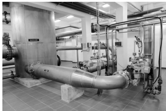
Obr. 2: Úpravna vody Kroměříž – Reakční nádrž směšování ozónu s vodou
