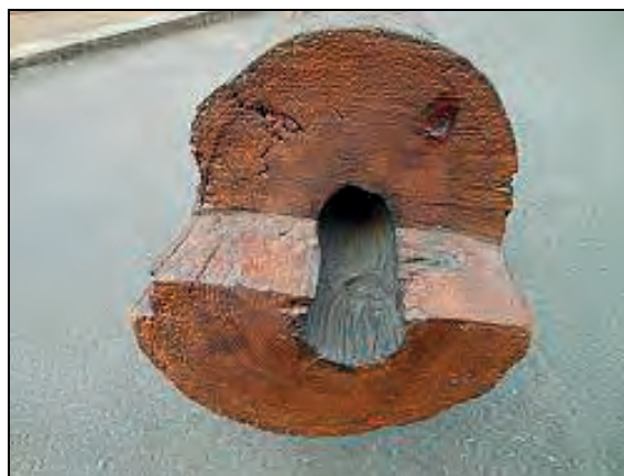
Obr. 2: Detail průtočného profilu dřevěného vrtaného potrubí
