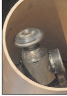
PRÁCE KANALIZAČNÍM ROBOTEM KAWO PRO LOKÁLNÍ OPRAVY POTRUBÍ
