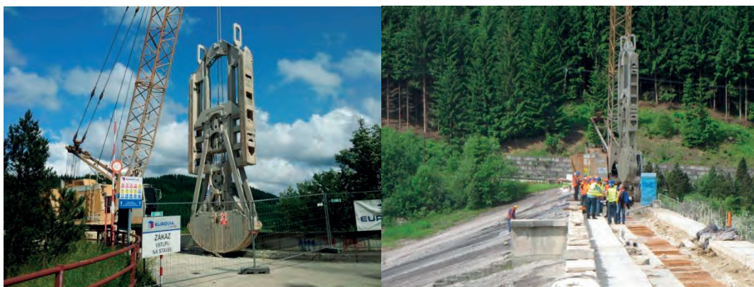
Obr. 2: Oprava nádrže-těsnicí jádro
