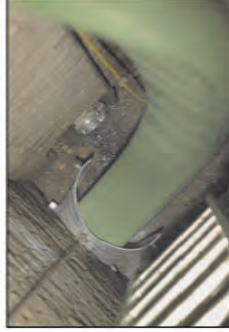
SANACE BEZVÝKOPOVOU TECHNOLOGIÍ OMEGA LINER
