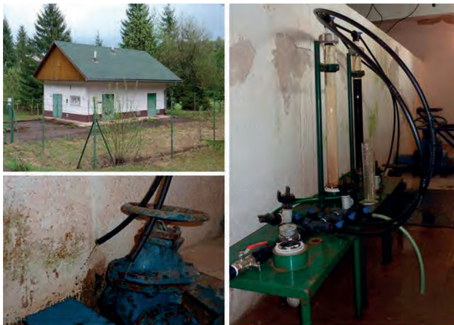
Obr. 1 Pohľad na vodárenský objekt v Dúbrave, použité zariadenie a odber vzoriek
