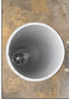
SANACE POTRUBÍ NÁSTRÍKEM TECHNOLOGIE SS SYSTÉM
