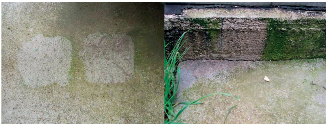
Obr. 3 Aplikace komerčních přípravků v reálném prostředí (beton)
