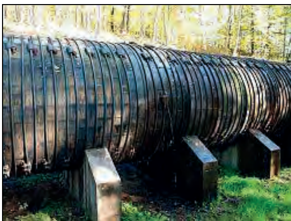
Obr. 3: Dřevěné dužinové potrubí DN 2000, které sloužilo jako přívod z VD Seč pro vodní elektrárnu
