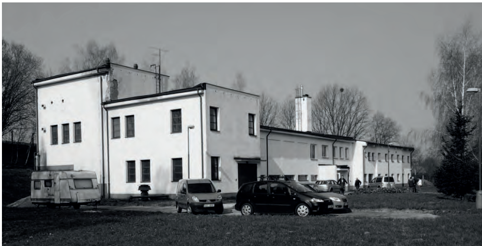
Obr. 1 Budova úpravný vody Březovice
