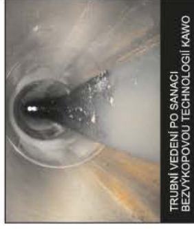
DIAGNOSTIKA PODZEMNÍCH TRUBNÍCH VEDENÍ TV - KAMEROU
