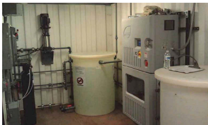
Obr. 8 Dezinfekce vody Apple Valey, California, 2013 na (Aquion MIOX Vault, kapacita 6,8 – 27,2 kg/d)
