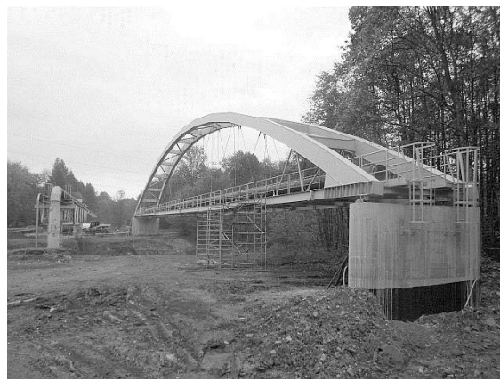
Obr. 8: Výstavba nového přemostění – pohled z levého břehu řeky Morávky. Původní trubní most je vidět vlevo od nového mostu.
