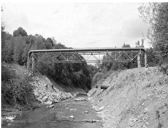
Obr. 1: Původní přemostění řeky Morávky (pohled po toku řeky). Vpravo jsou viditelné obnažené části zaslepeného potrubí původní dvouramenné shybky DN 800 (stav v roce 2011)
