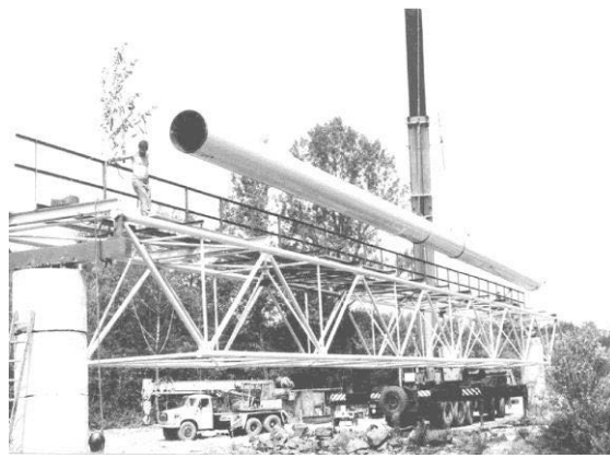
Obr. 4: Instalace ocelového potrubí DN 800 na původní přemostění v roce 1989
