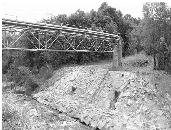
Obr. 2: Detail opevnění levobřežní opěry původního přemostění (pohled proti toku řeky). V opevnění je jasně vidět zaslepené potrubí původní dvouramenné shybky DN 800 (stav v roce 2011)
