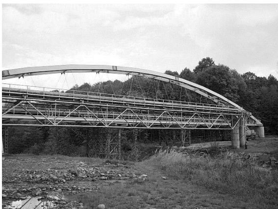
Obr. 7: Výstavba nového přemostění – pohled z pravého břehu řeky Morávky. V popředí je původní trubní most
