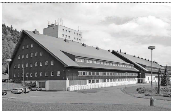
Obr. 2 Pohled na budovu úpravní vody
