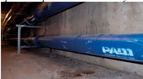
Speciální aplikace: rozvodní řady v kolektorech, uložení v objímce na konzole
