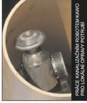
SANACE BEZVÝKOPOVOU TECHNOLOGIÍ OMEGA LINER
