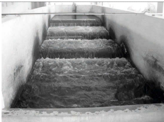
Obr. 3 Pohled na rychlé míchání - kaskáda
