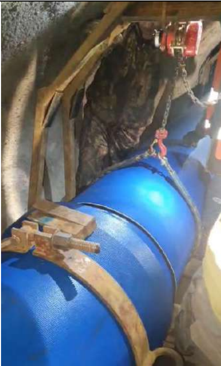
Obr. 6 Montáž potrubí ve štolě, nasouvání potrubí do hrdla.
