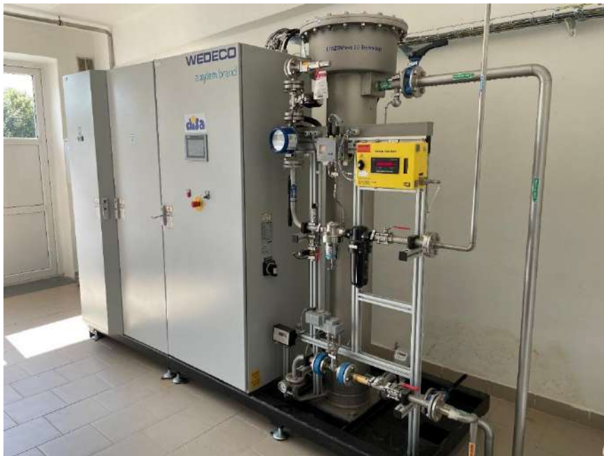
Obr. 3 Generátor ozonu WEDECO SMOevo Plus 410 s výkonem 1,5 kg/h O 3
