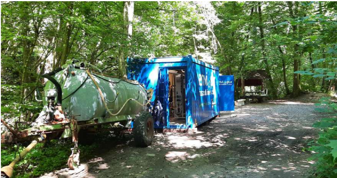
Obr. 3. Pohled na kontejnerovou membránovou úpravnu vody s připojenou mobilní nádrží na odpadní vody a turisticko-laboratorní altánek
