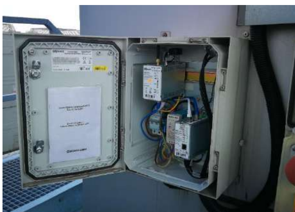
Obr. 2. - Ukázka přijímače včetně antény instalovaného na výškovém objektu
