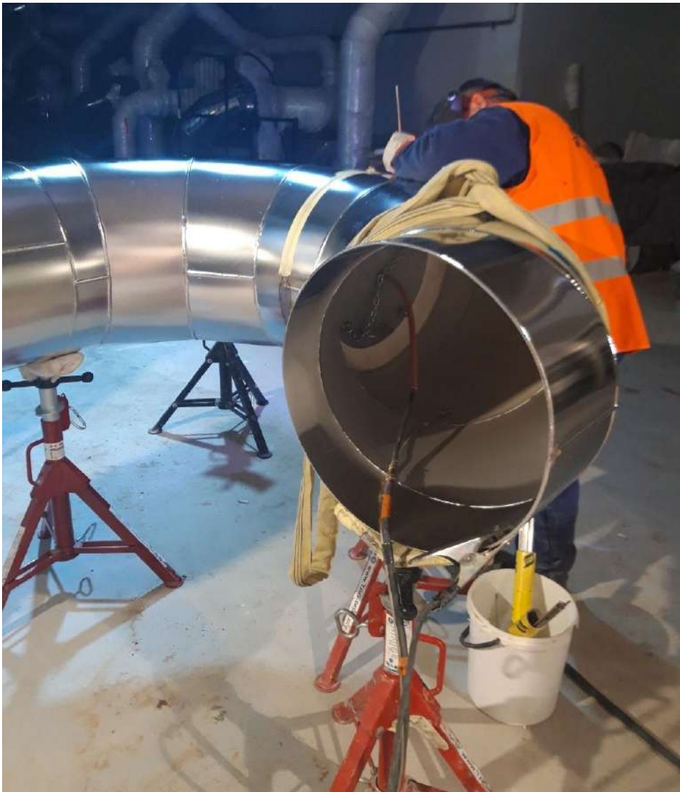
Obr. 4 Ukázka svařování a formování svaru segmentového kolena
