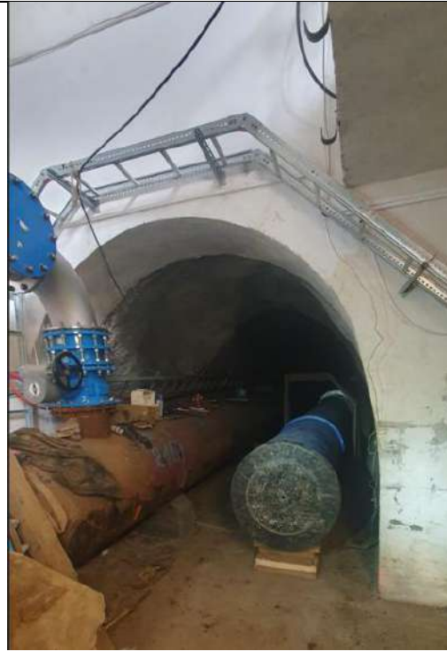
Obr. 5 Pohled z dolního portálu na poslední uloženou troubu ve štolě
