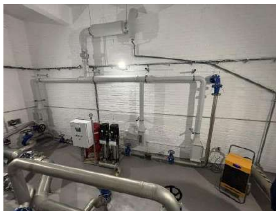
Obrázek č. 6 Stav po sanaci
