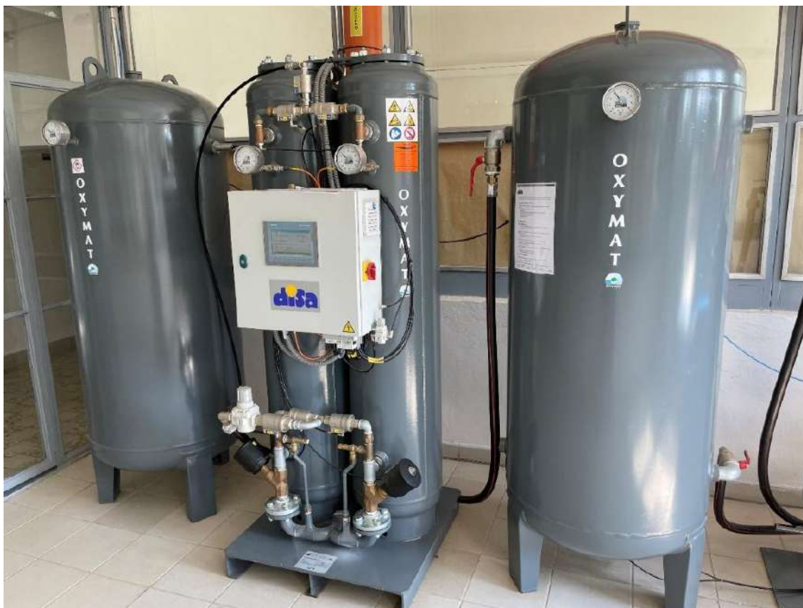
Obr. 2 Generátor kyslíku Oxymat s kapacitou 10 Nm 3 /h
