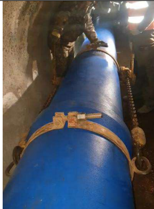
Obr. 6 Montáž potrubí ve štolě, nasouvání potrubí do hrdla.
