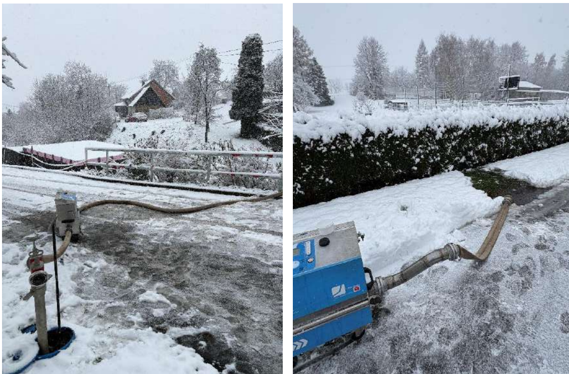
Obr. 2 Čištění potrubí metodou řízeného proplachu, technologie Astacus, klimatické podmínky v den proplachu: teplota vzduchu – 2 °C a sněžení.
