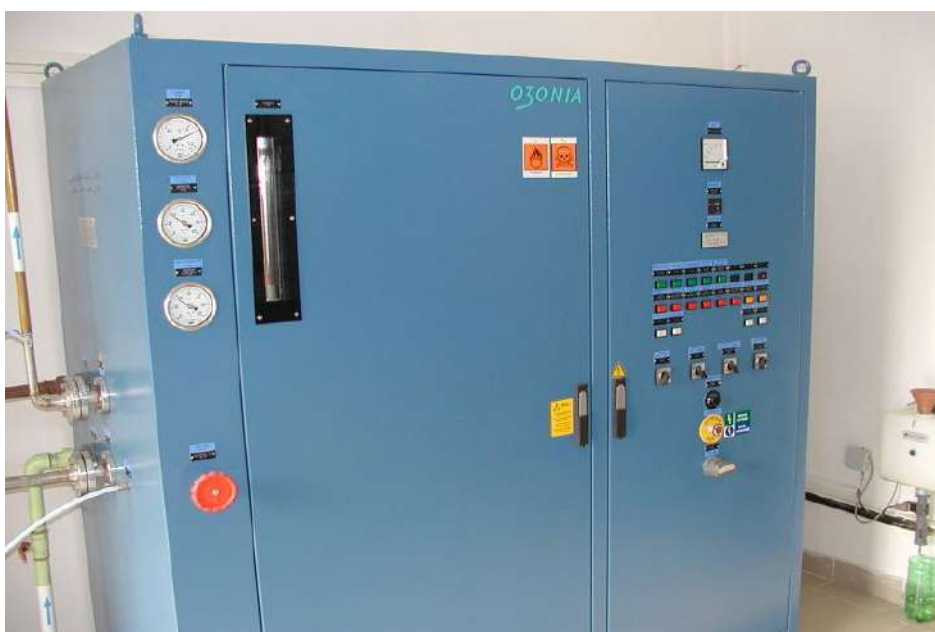
Obr. 1 Původní generátor ozonu Ozat CF 6A s výkonem 1,5 kg/h O 3
