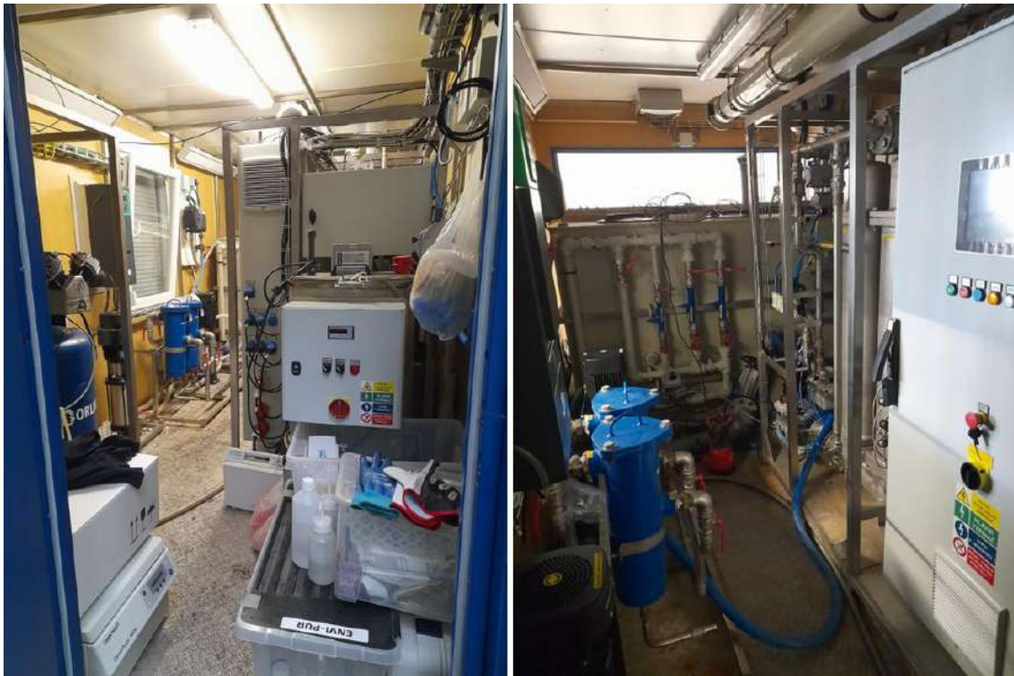
Obr. 2. Pohled do útrob kontejnerové jednotky s moduly keramických membrán
