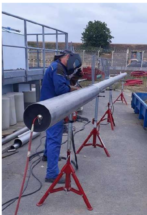
Obr. 2 Ukázka uzavření rovného potrubí a formování svaru
