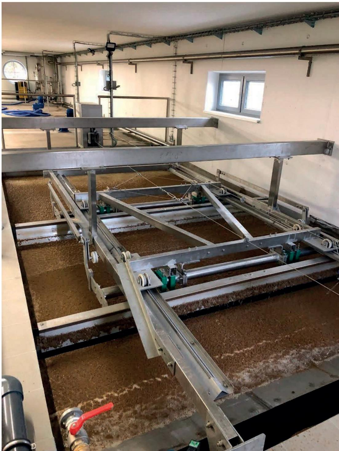
*Obrázek 5 1. separační stupeň - Flotace*
