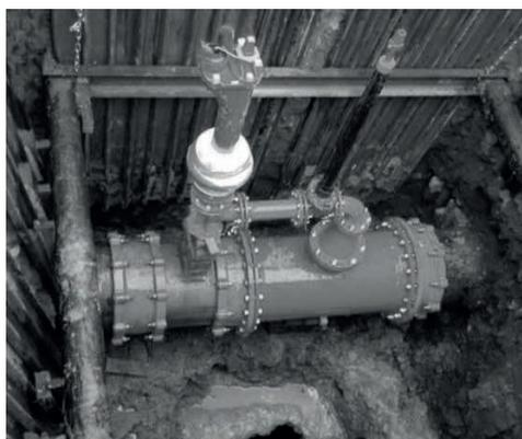
*Obr. 2 Podzemní hydrant s dvojitým odvodněním a drenážním blokem*
