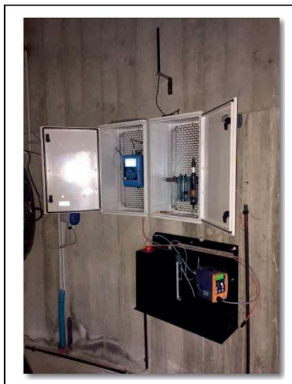
Za účelem dosažení správné úrovně dezinfekce je nutné, aby bylo možné dávkovat chlor i v objektech kde není elektrické připojení k napájení analyzátoru, čerpadla a regulátoru. Z toho důvodu byla provedena montáž regulačního ventilu, který je vybaven turbínou s elektronickým napájením, řídicí jednotkou D 22, sondou pro měření chlóru a dávkovací čerpadlem Prominent.
