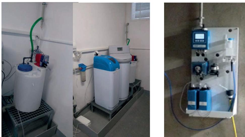
Obr. 2 Dávkovací nádrž na oxidanty, změkčovač a zařízení na měření koncentrace volného aktivního chloru
