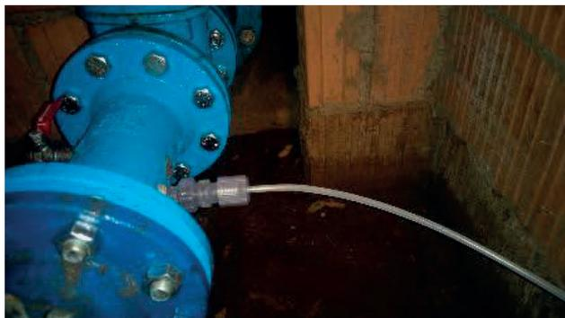
*Obr. 7 Dávkování oxidantu do potrubí je možné řídit spínáním, pomocí pulsního nebo napětového výstupu.*
