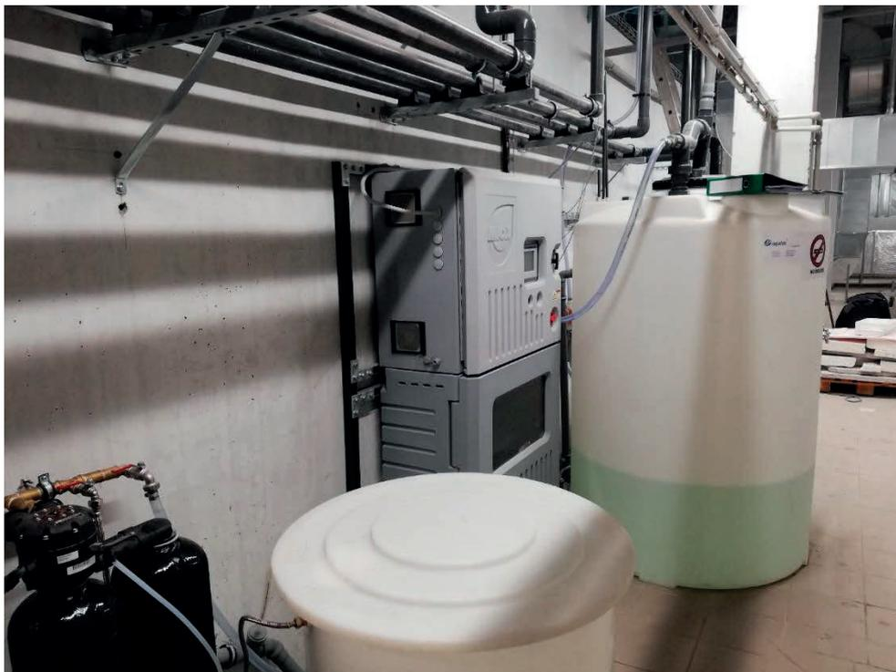
*Obr. 5 Pohled na linku generátoru Aquion MIOX Valut 15 M SC pro výrobu směsných oxidantů*
