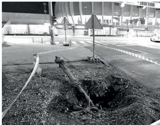
*Obr. 5 Nadzemní hydrant vylomený z potrubí*
