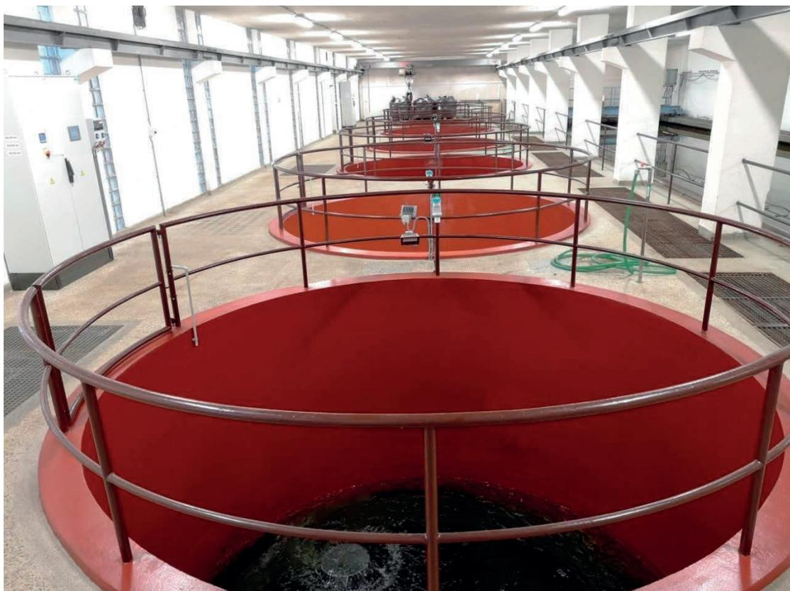
*obr. 1. Tři filtry s GAU a v pozadí část pískových kruhových filtrů*
